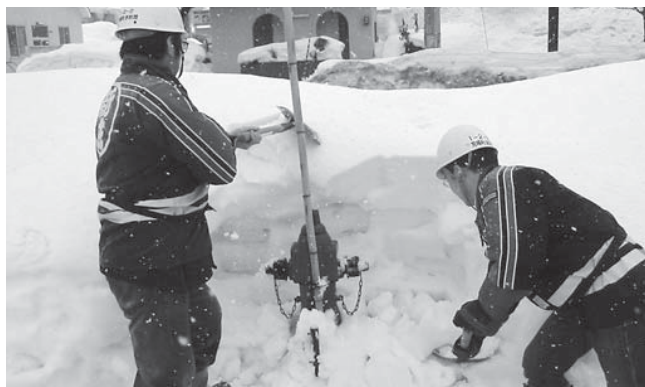
▲消火栓の除雪
