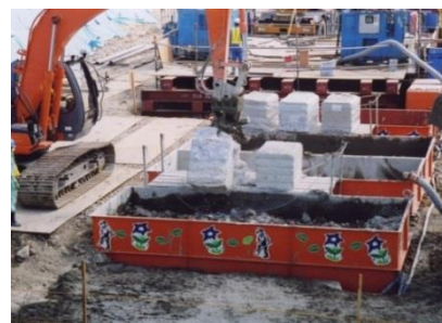
ボンテラン工法 施工状況
