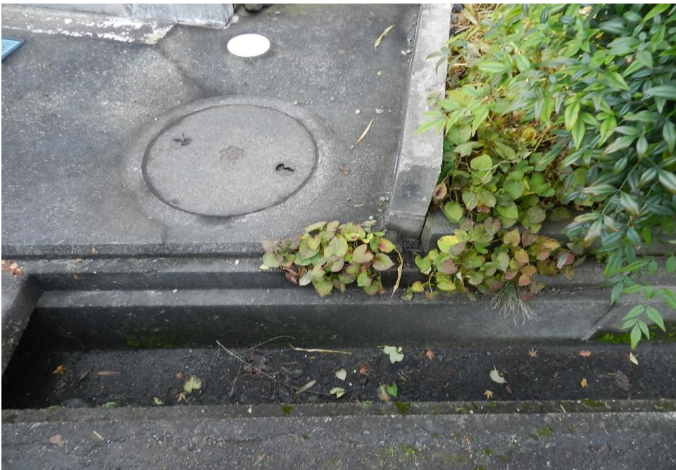
北東境界付近
