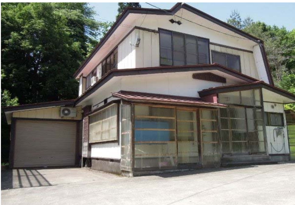
外観 南東側、南西側 車庫入口
