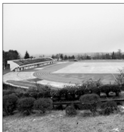
12月 陸上競技場改修工事完了
