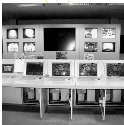
エコプラザがみ基幹的設備改良工事
