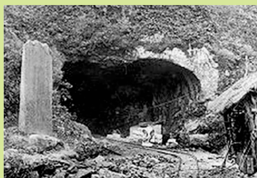
▲明治14年に開通した初代栗子隧道米沢側坑口
