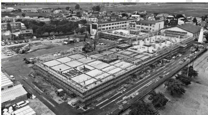
明倫学園建設工事の様子
