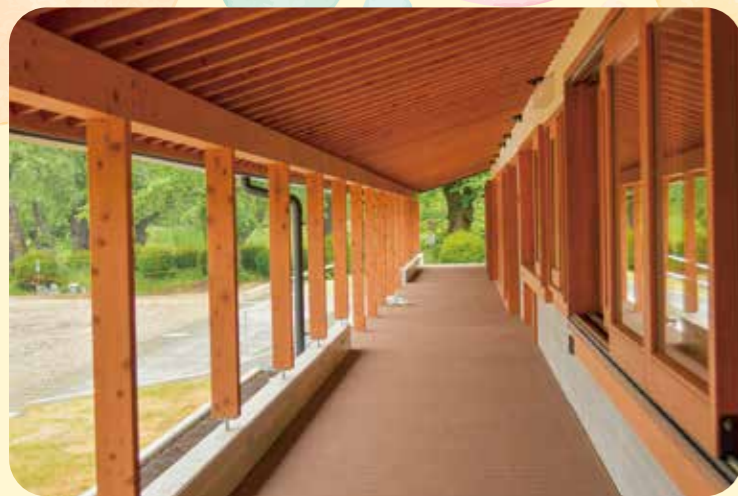
▲最上公園側に開放できるオープンデッキスペース
