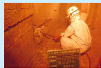
▲エコプラザがみプラント設備点検の様子
