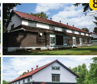
8. 旧農林省蚕糸試験場新庄支場 第二蚕室
