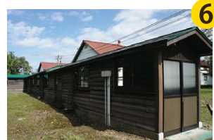
渡廊下及び便所
