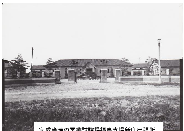
完成当時の蚕業試験場福島支場新庄出張所
