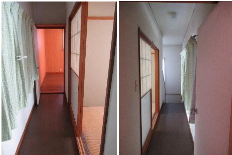
2階 廊下 (階段側から、洋室側から)
