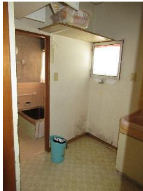
1階 洗面脱衣室
