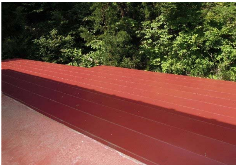
1F 台所先の屋根 改修済み
