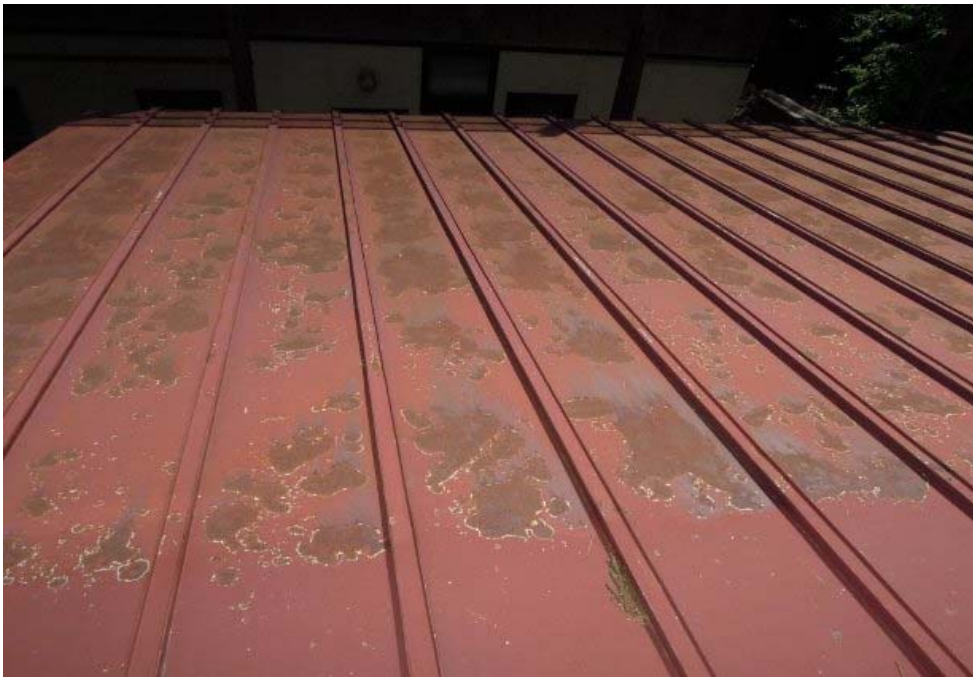
1F 車庫部分の屋根
