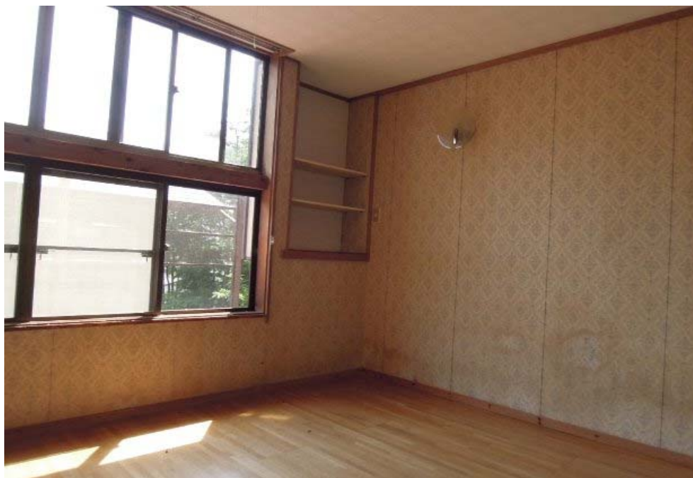
2F 多目的スペース 和室隣
