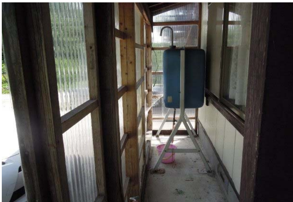
玄関脇風除室
