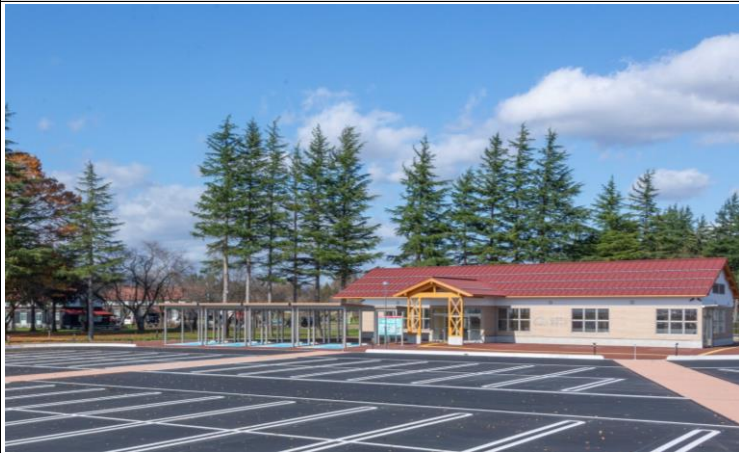
道の駅「新庄エコロジーガーデン原蚕の杜」 情報提供・休憩施設整備事業
