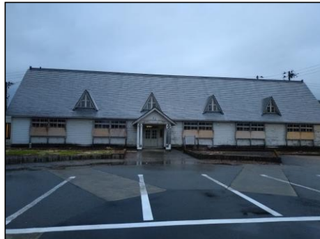
■現況写真(正面・裏側)
