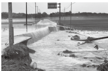
冠水した道路
