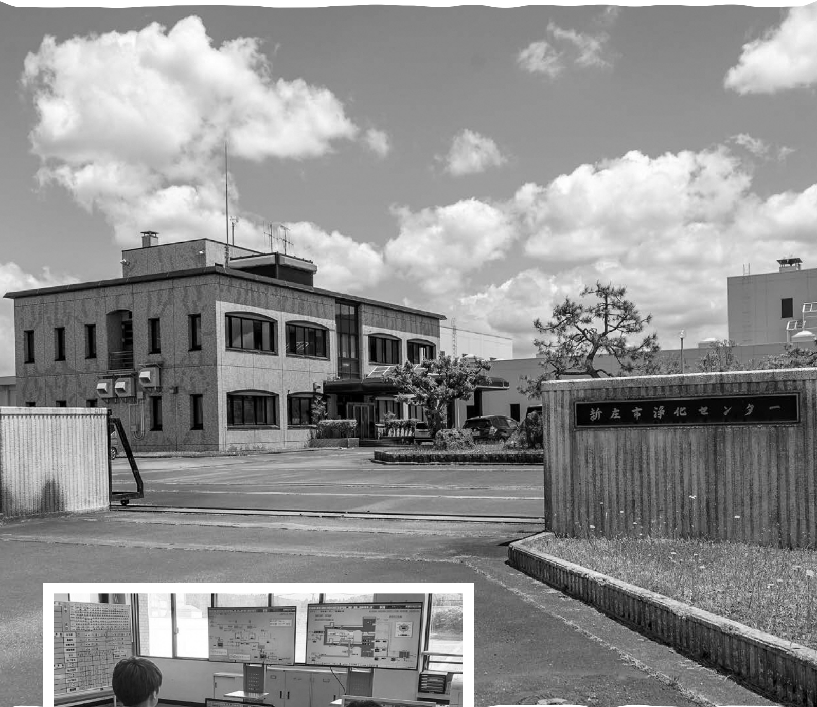
【新庄市浄化センター】
