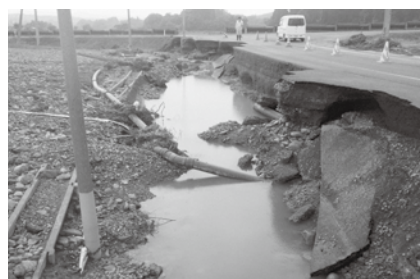
法面が欠落した道路
