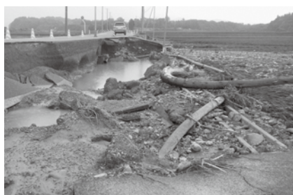
法面が欠落した道路
