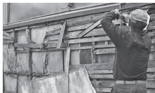
耐震基準前の建物構造内部の一例（市内建物）
