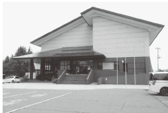
築36年経過したふるさと歴史センター
