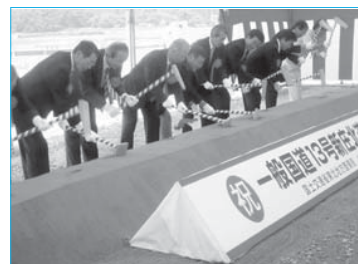
▲国道13号新庄北道路の着工を祝った起工式(7月31日/飛田地区)
