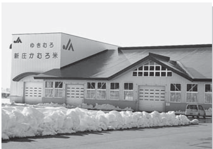
■ 新庄市農業協同組合ゆきむろ新庄かむろ倉庫 約1,000トンの圧縮した雪を格納し、雪の冷気を利用して、室温を摂氏14℃、湿度70%に保ちます。米や野菜の貯蔵のほか日本酒やそばなどの低温貯蔵庫としても活用されています。
