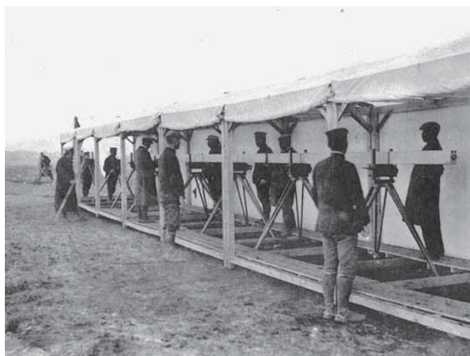
図5 明治15年頃の相模野基線の測量の様子
