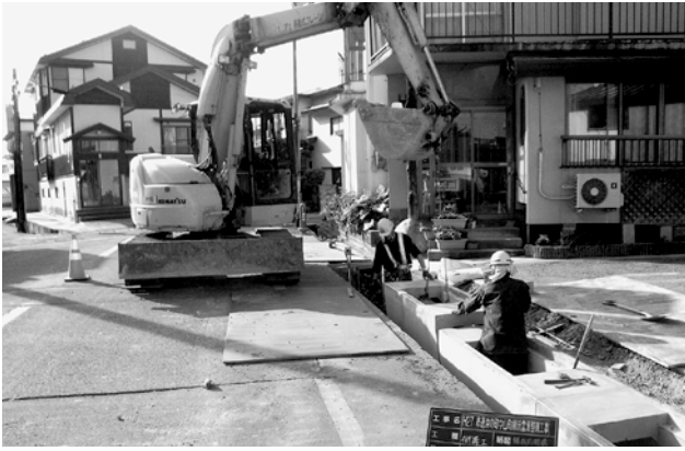
▲沖の町・中山町地区と金沢地区外の2地区で実施した流雪溝工事
