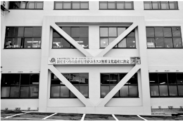
▲市役所本庁舎耐震補強工事
