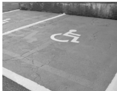
▲障がい者等用駐車場塗装完成。
