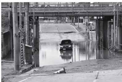
▲高架橋下の浸水(金沢地内)
