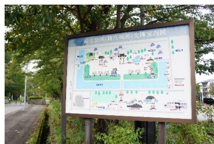
老朽化した案内看板
