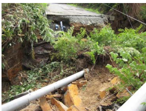
豪雨による管路被害状況 (H30.8.5)
