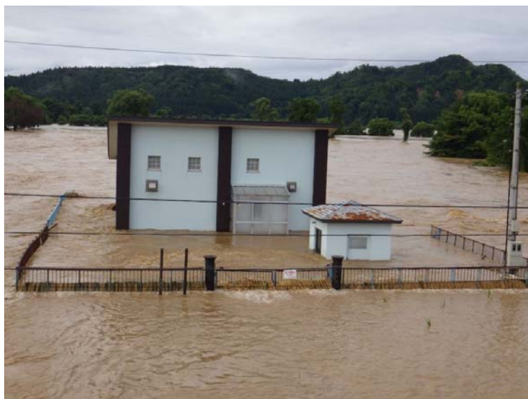
畑浄水場豪雨被害状況 (R2.7.28)
