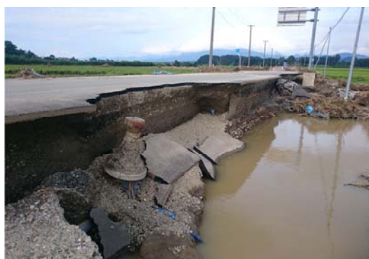
豪雨による管路被害状況 (H30.8.5)
