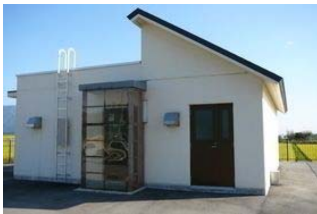
萩野送水ポンプ場
