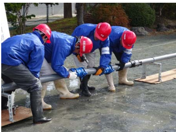
施設復旧訓練
