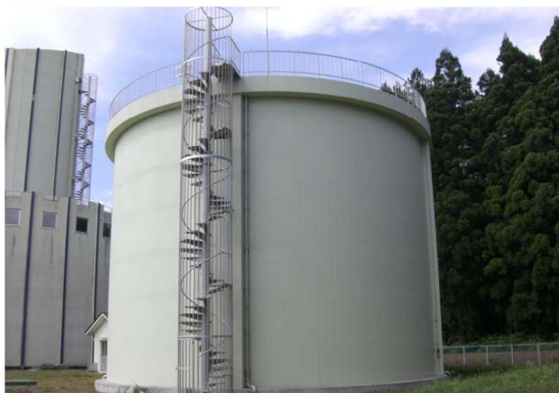
指野第2 低区配水池
