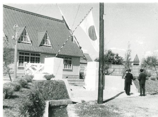
ドーマ窓が撤去される以前の旧雪調
